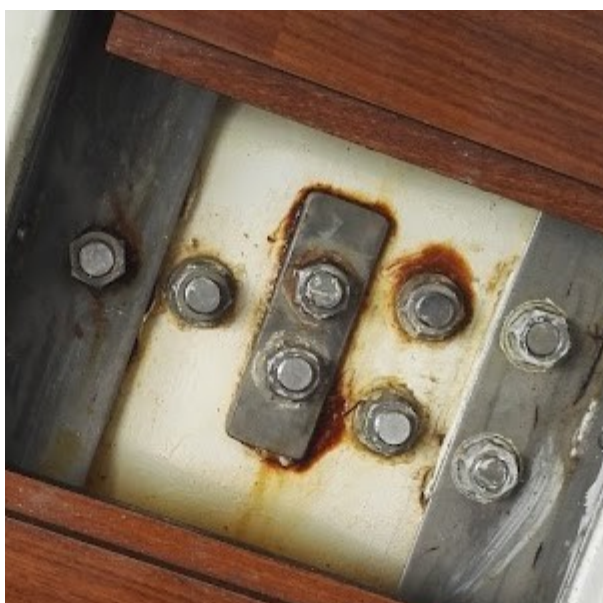
Kölbultar med misstänkt korrosion
