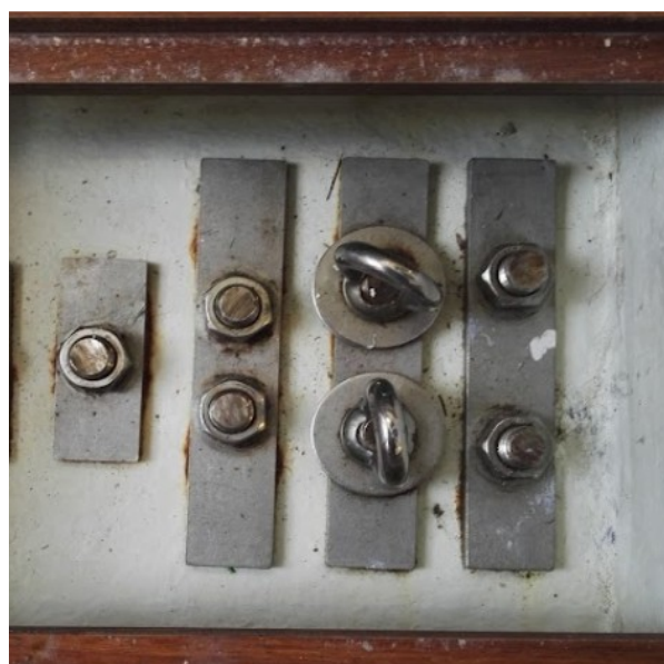
Kölbultar utan spår av korrosion
