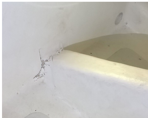
Bottenstock-kojfront efter grundsstötning
