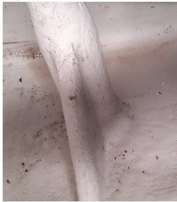
Insidan vid nedre roderlager, inga skador
