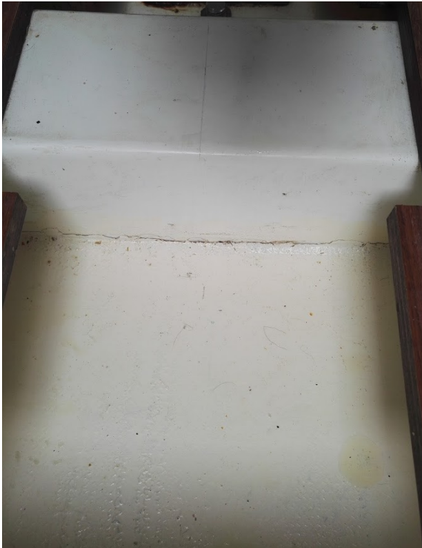
Bottenstockar med misstänkta skador
